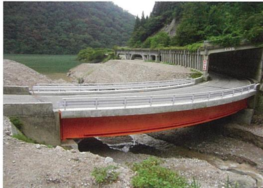
工事概要 土石流によって損傷した橋梁の原型復旧工事
