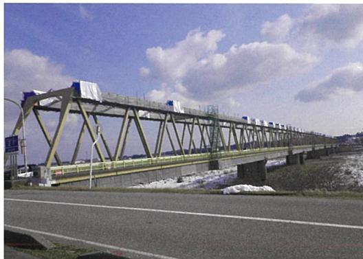
工事概要 トラス橋連結部の老朽化に伴う補強工事
